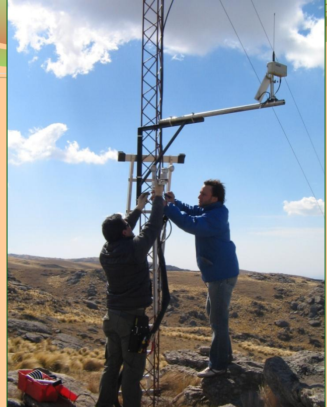
Instalación de estación automática
